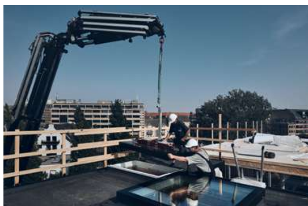
4 - Colocação do vidro
