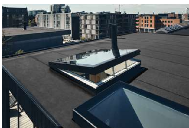
6 - Ligações elétricas no módulo de ventilação natural
